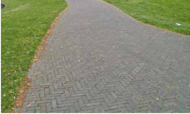
de wegen zijn sharedspace: tapijt van gebakken klinkers waarop auto- en langzaamverkeer samen voortbewegen
