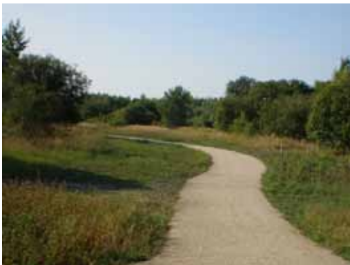
de paden worden gemaakt van halfverharding
